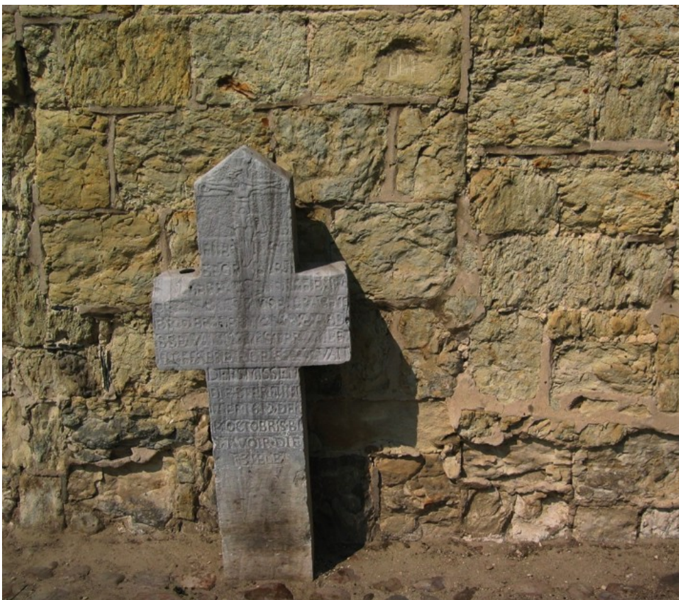
Detail van het schip van de Guvelingenkapel met sterk door vorst verweerde Tuffeau van Lincient (ontbreken van een beschermende kaleilaag). Op de voorgrond een stenen grafkruis in grijze Maaskalksteen. FOTO ROLAND DREESEN
